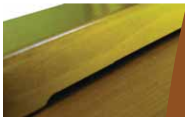
Flügelfräsung (Zuluftöffnung) auf der Rauminnenseite
